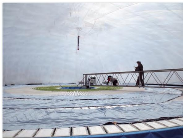
陸前高田市の太陽光を活用する膜構造のドーム型植物工場。中心部で苗を植え付け、成長に伴い渦巻状に外側に移動。1ヵ月後に外縁部で収穫するまで人手がからない自動管理が特徴
