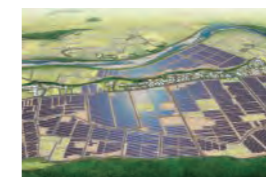
福島県浪江町谷津田地区 メガソーラー発電所
