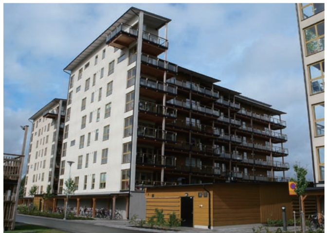
スウェーデン・ベクショー市。高密度の集成材、独自工法により、鉄やコンクリートと同等の耐火性能と強度を実現した木造8階建て住宅。国内資源の利用と雇用創出に貢献している。
