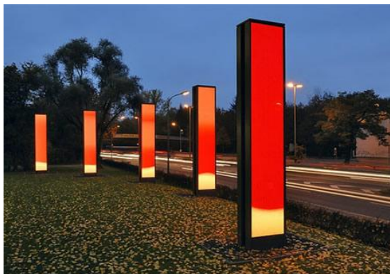
・太陽光発電24時間対応の街路灯設置
