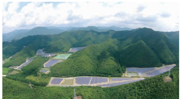
写真提供：多可町安田郷メガソーラー発電合同会社
