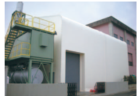
堀河町終末処理場に 設置された汚泥乾燥施設
